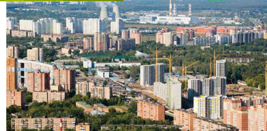
В Мытищах полностью перестроена тепловая сеть, потери сократились на 22%
